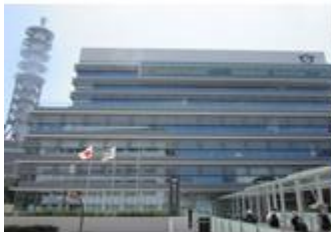
藤沢市役所・新庁舎
